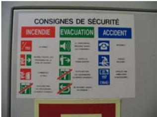
Panneau d'instruction, placés par exemple à proximité des postes d'extinction ou des déclencheurs manuels
